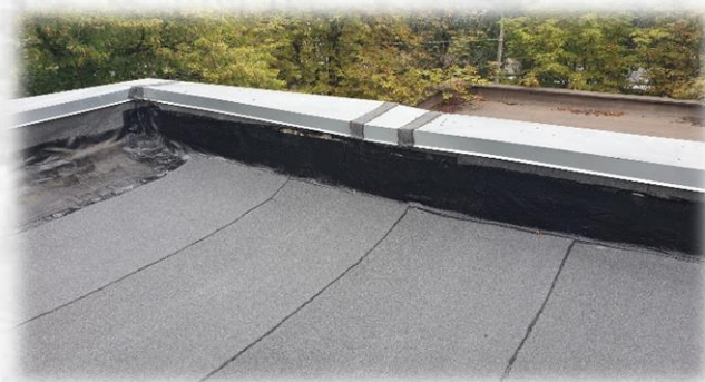
Ремонт кровли д/с № 69
