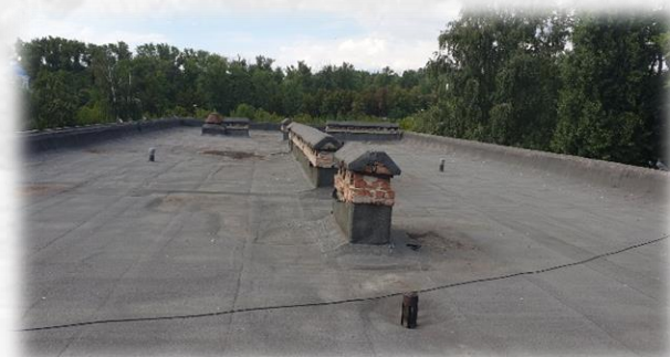
Ремонт кровли д/с № 54
