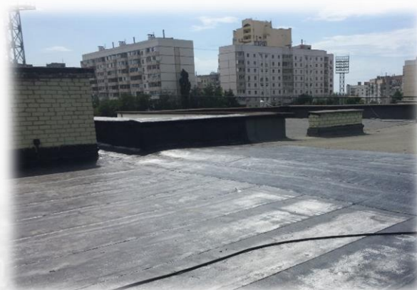
Ремонт кровли МБОУ СОШ № 49
